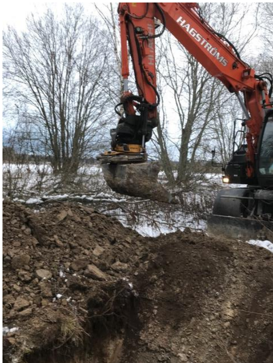
Figur 13. Grävning av provgrop ÅF1803
