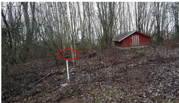
Figur 9. Bergborrard brunn i det lilla huset, en trolig dagvattenbrunn till vänster om brunnshuset (inringad med rött) och grundvattenrör, ÅF1801gv, i förgrunden.
