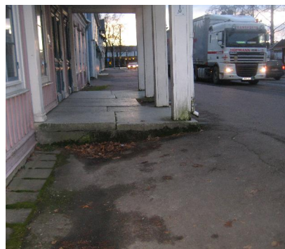
Marknivån mot Storgatan är högre idag, trappan upp till entrén är inte kvar. Foto: WSP
