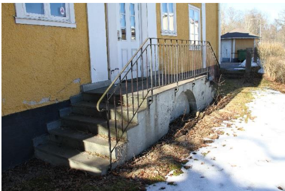
Bild 7. Trappen till trädgården på byggnadens östfasad.
