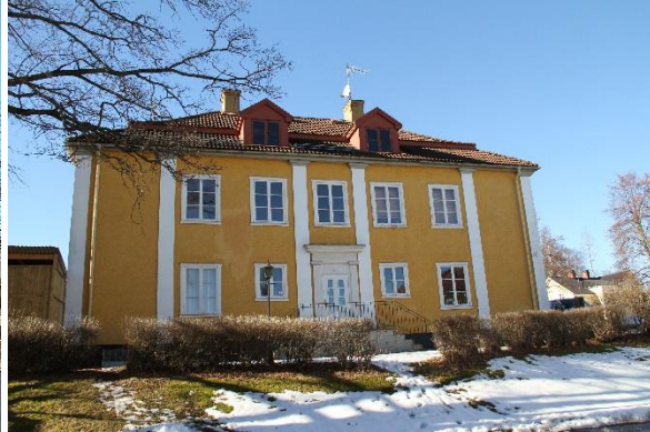
Bild 4. Köpmangården, fasad mot öst.
