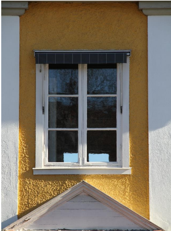
Bild 11 .Fönster och tympanonfält. Fasad mot väst.
