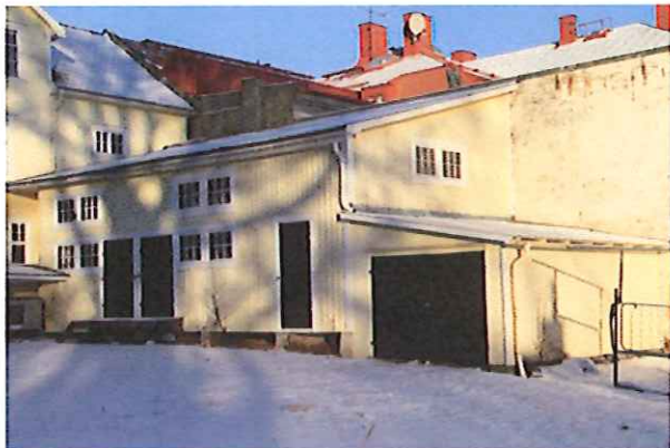
Packboden, fasad mot väst och söder.
