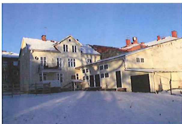
Fasad mot söder med lagerbyggnaden.
