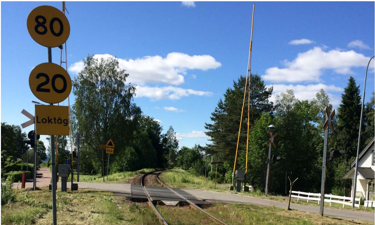
Bild 9. Hastighet på Fryksdalsbanan vid södra järnvägsöverfarten vid Sundets handelsplats.
