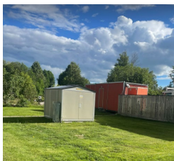
Till vänster: Bild på transformatorstationen i området.
