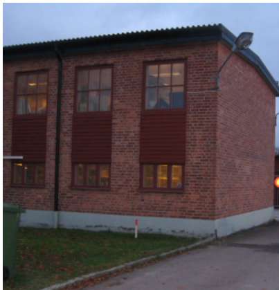
Sundsvik 10:10. Fasaden mot västra sidan med nya fönster.
