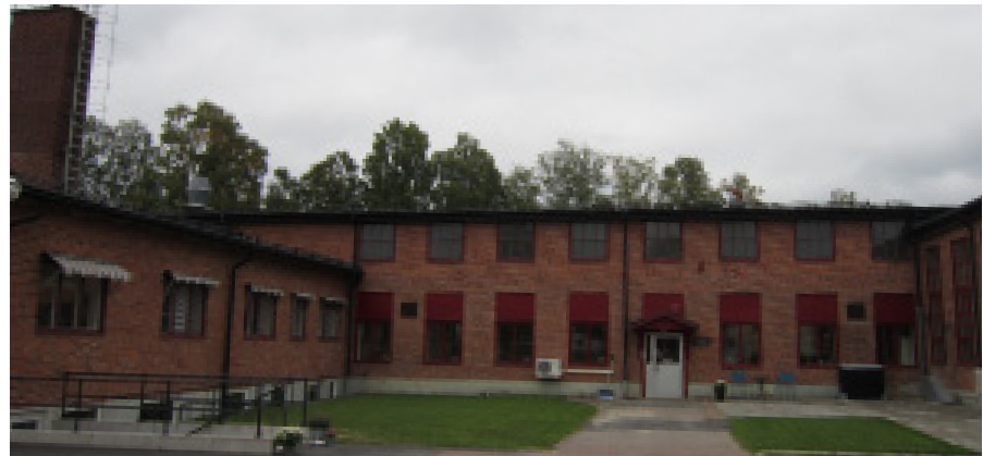
Huvudbyggnaden från västra sidan mot järnvägen
