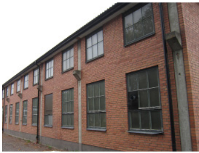
Fasaden mot östra sidan med gamla fönster.
