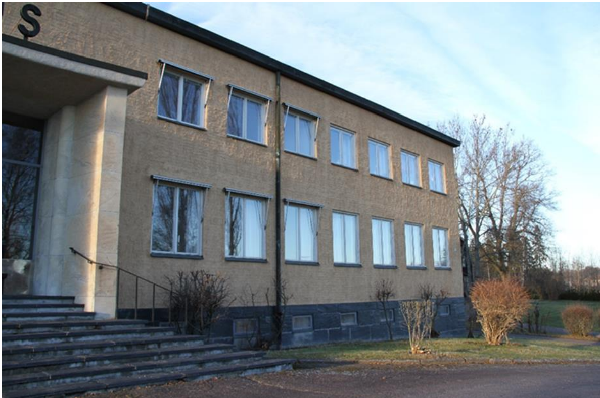
Bild 4. Tingshuset, del av fasaden mot öst.
