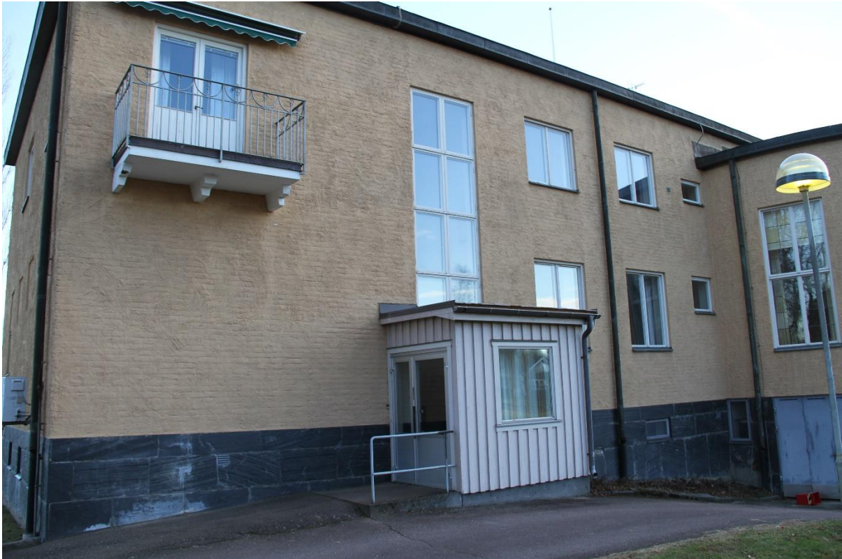
Bild 13. Tingshuset. Byggnadens nordvästra hörn. Här ser vi den för tiden mycket tidstypiska placeringen av balkongen samt ett senare tillbygge för handikappanpassning.
