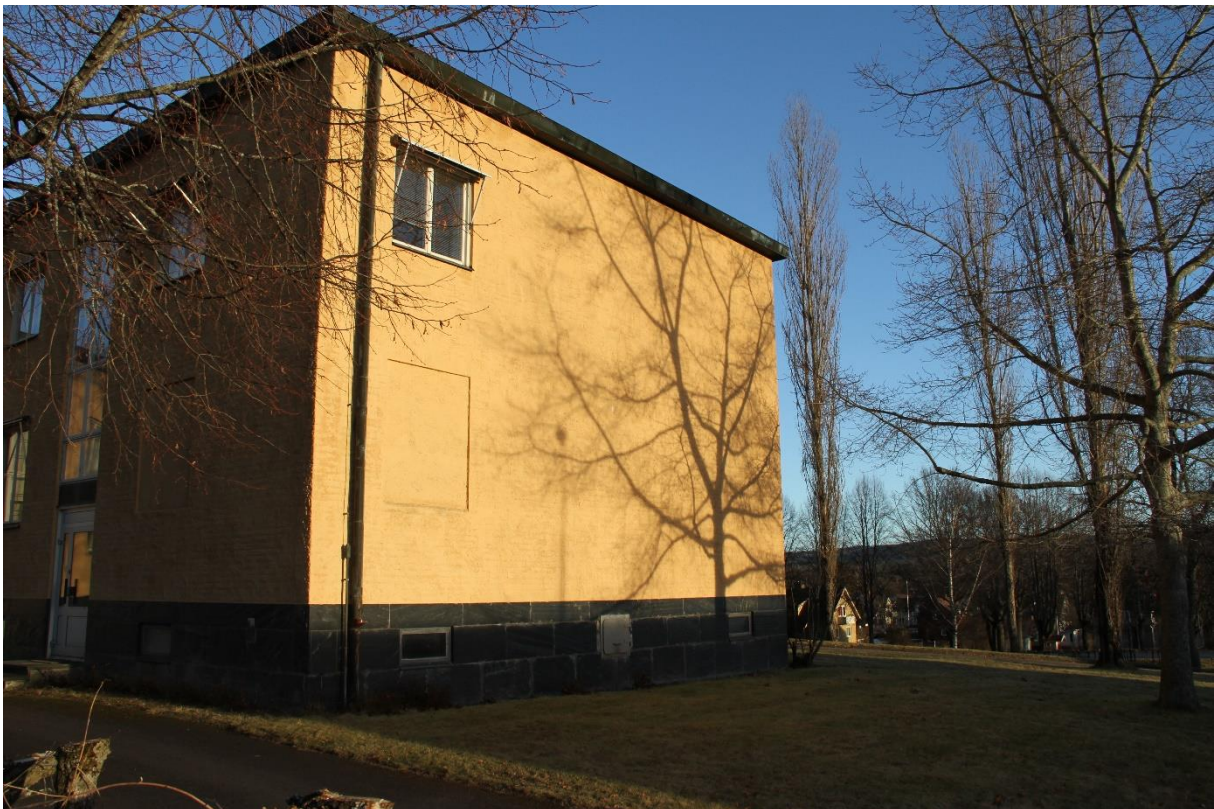
Bild 11. Tingshusets fasad mot söder.
