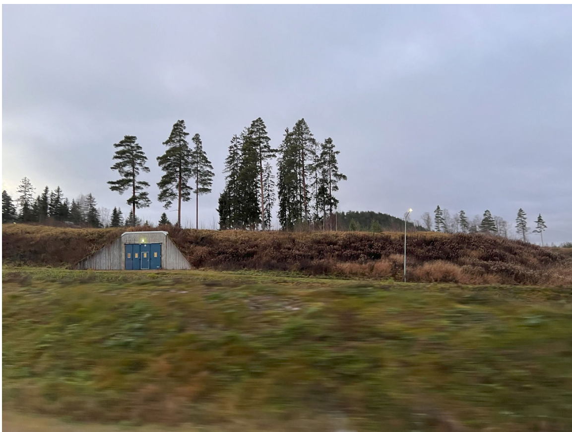
Figur 21: Bild över Torsby skidtunnel sett från E45.
