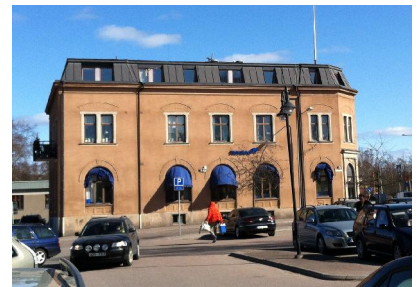
Befintlig bebyggelse på Sundsvik 1:26, kvarteret Banken, som angränsar planområdet på östra sidan.
