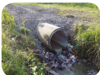
Exempel på hantering av dagvatten med öppna diken och trumma under grusad väg/överfart.
