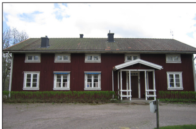
Bostadsbyggnad från år 1978
