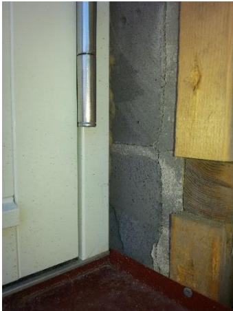
Figur 18. Delvis blottad yttervägg vid nyinsatt dörrparti. Möjligen kan del av yttervägg bestå av blå lättbetong.
