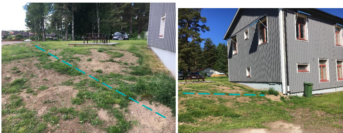
Figur 6a och b. Ungefärlig sträckning av ledning till energi brunn i berg
