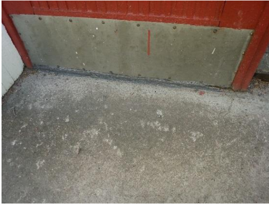
Figur 15. Fog i underkant entréparti. Enda noterade förekomsten av fogmassa.
