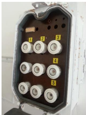
Figur 9. Gnistskydd i proppskåp.
