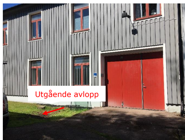
Figur 8. Utgående avlopp från byggnaden
