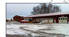
Lokstallet + lokaler i södra delen av området
