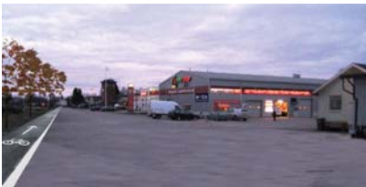
Ny gång- och cykelväg längs järnvägen/Industrigatan
