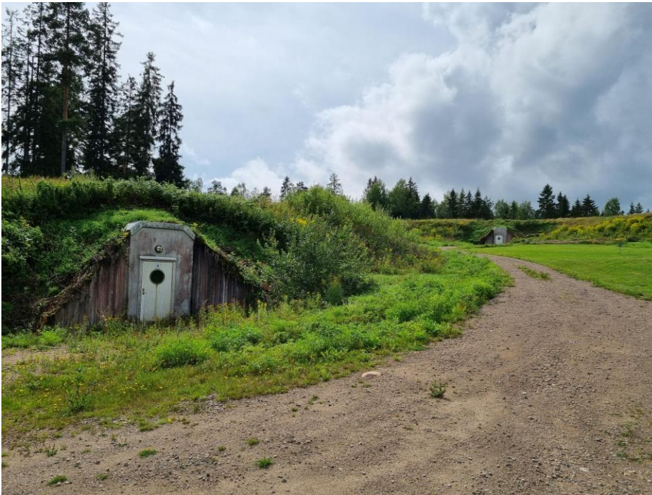
Figur 7: Möjlig framtida gestaltning av de föreslagna tunnlarna på anläggningen. Bilden visar skidtunneln i Torsby. Anläggningarna på Climate Arena planeras följa samma princip med tunnlarna och anläggningar som delvis täcks av vegetation och följer områdets terräng, slutlig utformning är dock inte fastställd. På bilden syns även entréer för underhåll av tunneln.
