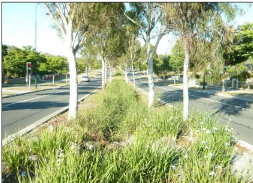
Figur 17. Biodiken, principskiss och exempelbild från ett vägparti i ett sydligare land. Bild: Larm och Blecken 2019. Observera att biodikena inom planområdet föreslås anläggas utan dräneringsrör.
