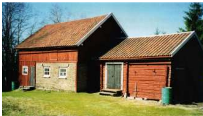
I skogrika bygder har trä varit det huvudsakliga byggnadsmaterialet. Här syns olika byggnadstekniker: Ett timrat uthus, en ladugård med väggar av kubb i djurhållningsdelen och panelad brädkonstruktion för dasset.
