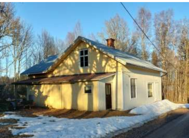
Handelsboden uppförd 1900. Foto: EPG/WSP.
