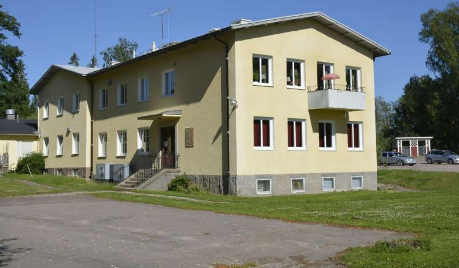
Sunnes gamla kommunhus från 1942. Arkitekturen är enkel och sparsam. Tidstypiska detaljer återfinns exempelvis den enkla dörrumfattningen, de putsade fasaderna, fönstren utan spröjs, skärmtaket över entrén och balkongen med smidesräcke och korrugerad plåt. Sadeltaget är flackt och till höger om entrén sitter Sunnes kommunvapen som berättar om byggnadens ursprungliga syfte.
