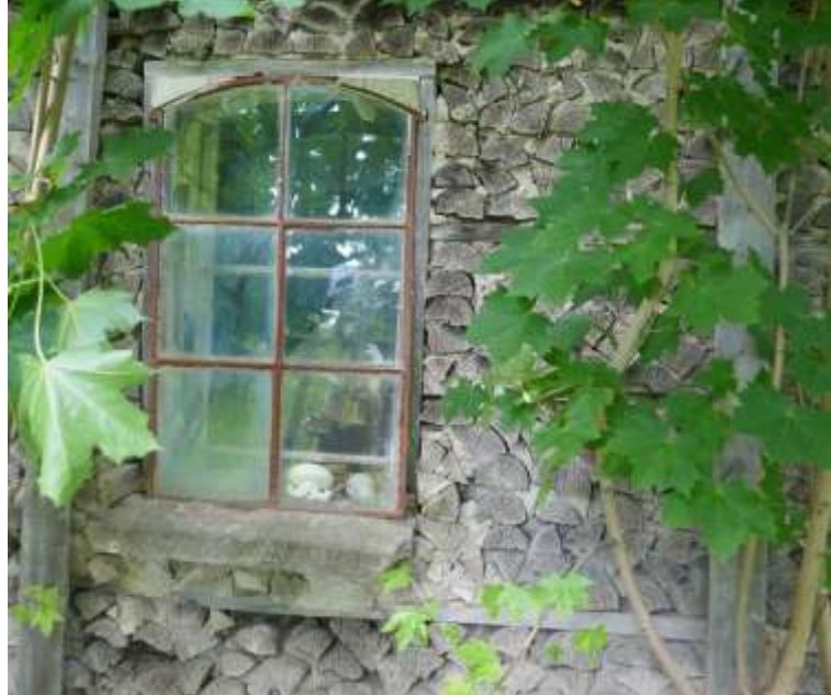
Kubbhusteknik har varit ett sätt att använda enklare och billigare material. Det var vanligt under 1900-talets första hälft. Denna ladugårdsbyggnad har även fönster i gjutjärn.
