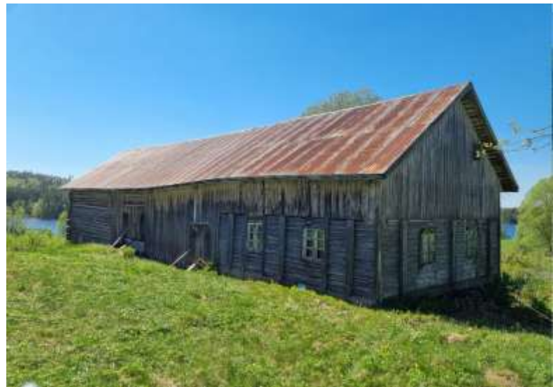
Äldre ladugård i timmer och regelverk med obehandlade fasadytor.
