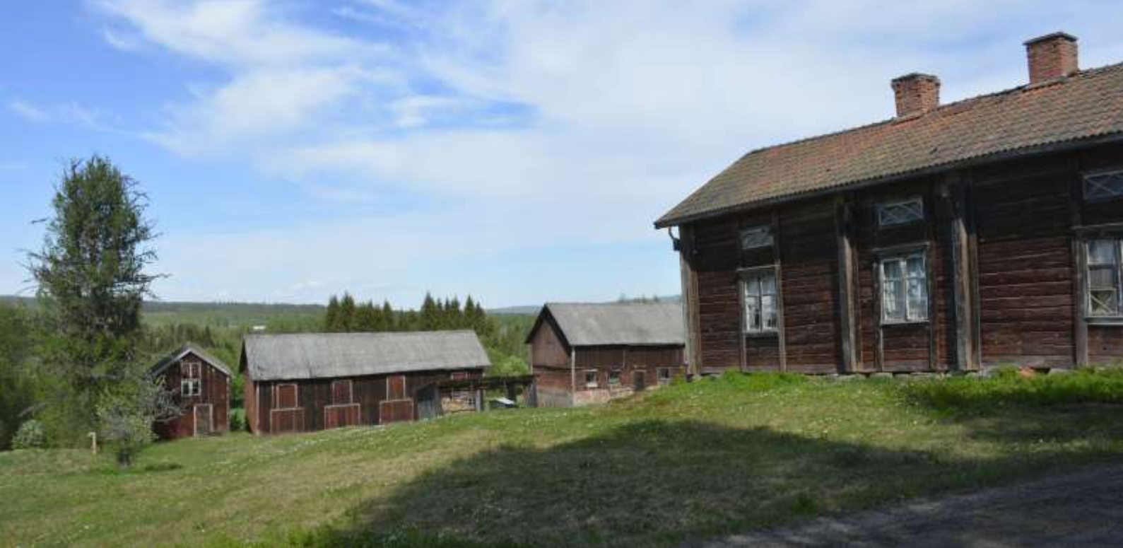
Äldre bevarad gårdsmiljö i Fagerstad med timrad parstuga till höger i bild och nere i slänten ett antal ekonomibygnader. Foto: EPG/WSP
