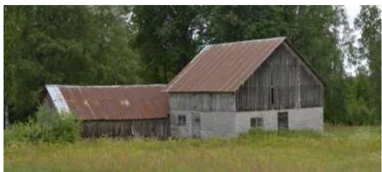
Under 1900-talet kom nya moderna byggnadsmaterial som betongsten och plåttak. Byggnaderna från denna tid är ofta enkla och berättar om den utveckling av jordbruket. Dessa är också värdebärande i det särskilt värdefulla området.
