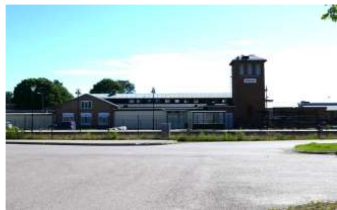
Delar av Fortums byggnad utgörs av möbelfabriken tidigare lokaler i rött tegel. Det är en del av Sunnes äldre industribyggnad, vilken är av stor betydelse för att förstå tätortens utbyggnad under 1900-talet.
