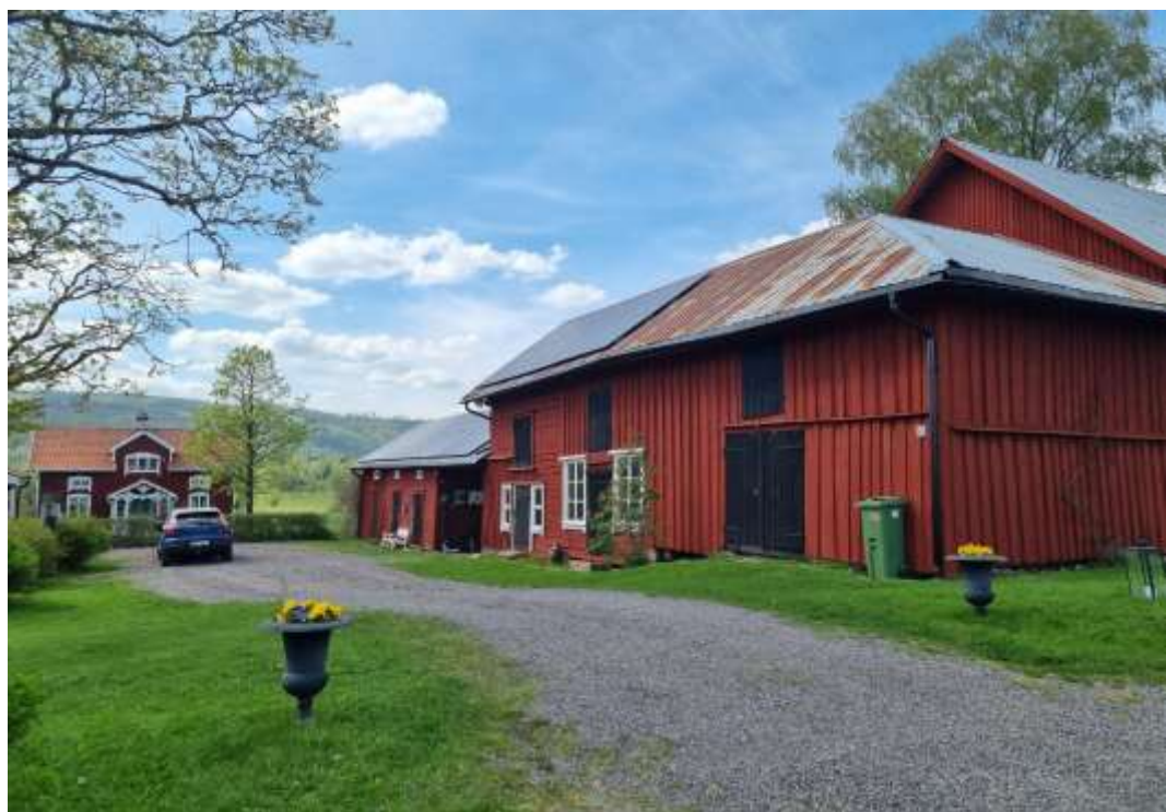
Gårdsmiljö i Bråsstorp. Till vänster mangårdsbyggnaden, till höger bod och ladugård i timmer som målats med röd slamfärg. Den vinkelbygda lekonomibyggnaden är typisk för det sena 1800-talets och tidiga 1900-talets gårdsbebyggelse. Foto: RL/WSP.
