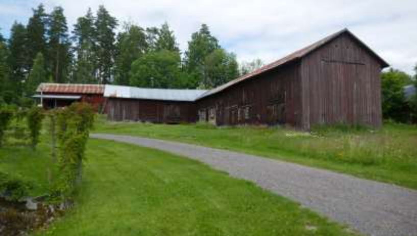
Ekonomibyggnad, sammanbyggd av delar utförda i olika tekniker. Det finns en timrad del och en del är också utförd i kubbhusteknik. Gräsmarken.
