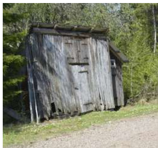
Uthus/ekonomibygnad vid Popetorp. Foto: EPG/WSP.
