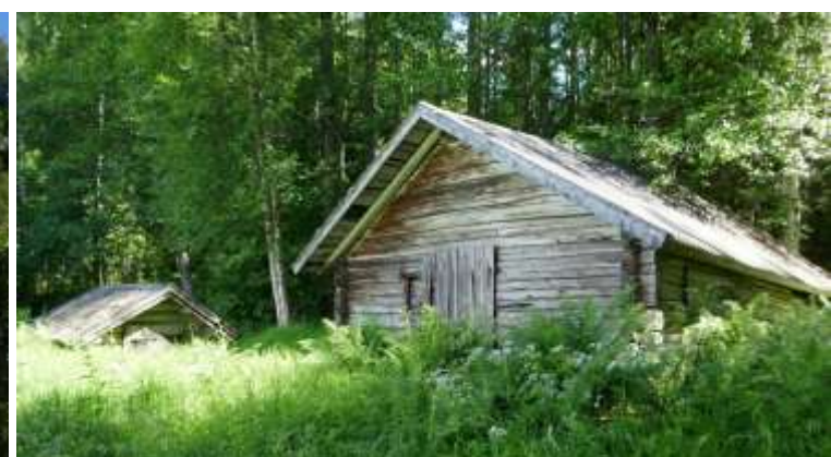
Kölnan och smedjan, två välbevarade älderdomliga timmerbyggnader.
