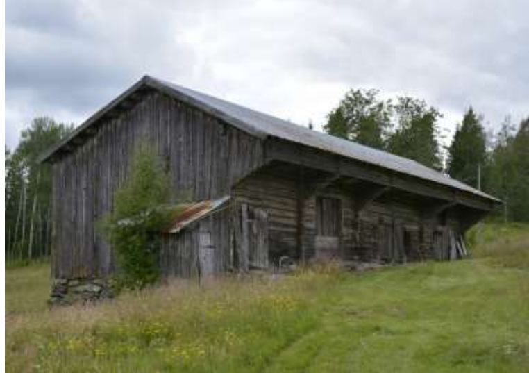
Ladugård i Bartelstorp, med svale längs hela långsidan och på gaveln ett vidbyggt dass.
