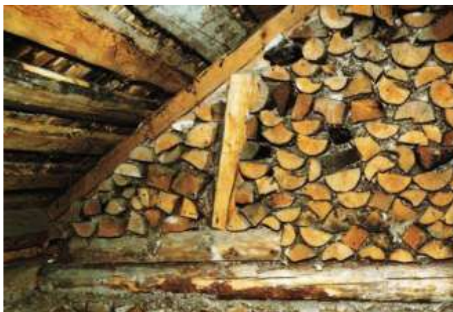
Kubbbhusets vägg från insidan. Här är ett boningshus murat upp tillnocken med kubb.
