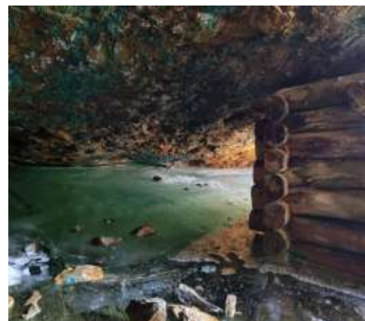
Vattenfyllt schakt vid Källargruvan. Foto: RL/WSP.
