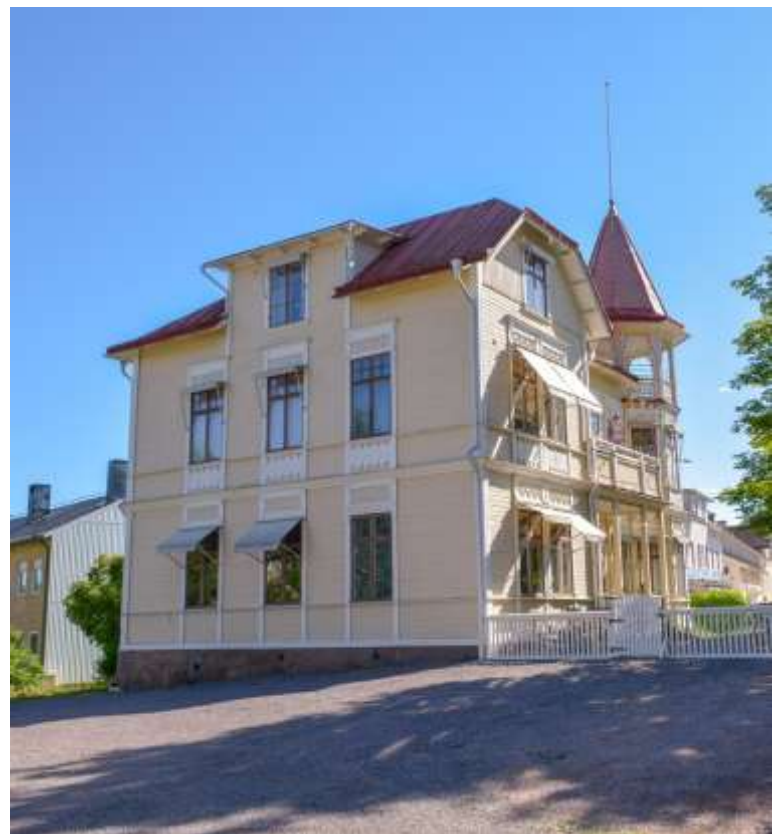
Villa Helios uppförd 1904, rikt dekorerad med snickerier och stående och liggande panel med en tydlig kontrastverkan i fasaden.
