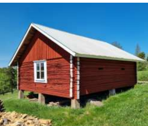
Äldre timrad ekonomibygnad i Borrsjön. Foto: RL/WSP.
