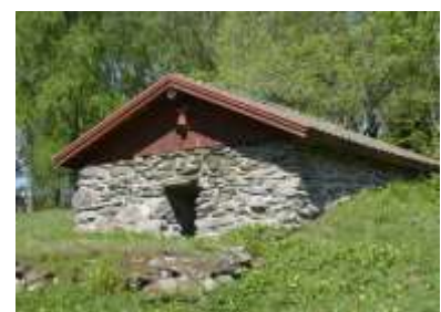
Jordkällare. Foto: EPG/WSP.
