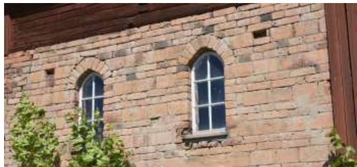
Detalj av en av Askersbys ekonomibygnader i mönstermurat tegel och timmer.
