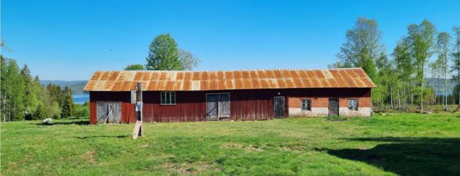
Ladugård med murad djurhållningsdel i rött tegel. Foto: RL/WSP.
