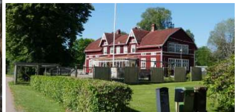
Lerans skola vid Ekebyvägen uppförd 1912. Det fanns från början en likadan skola i Klockargården, men den brann ned 1930.
