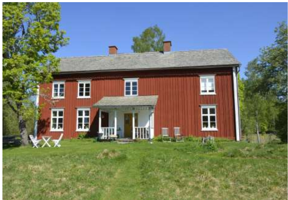
Gården Där Sör med manbyggnad i två våningar med väl bevarad karaktär. Foto: RL/WSP.
