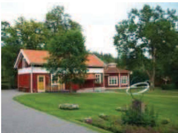
Bild 33. Den östra flygeln.
