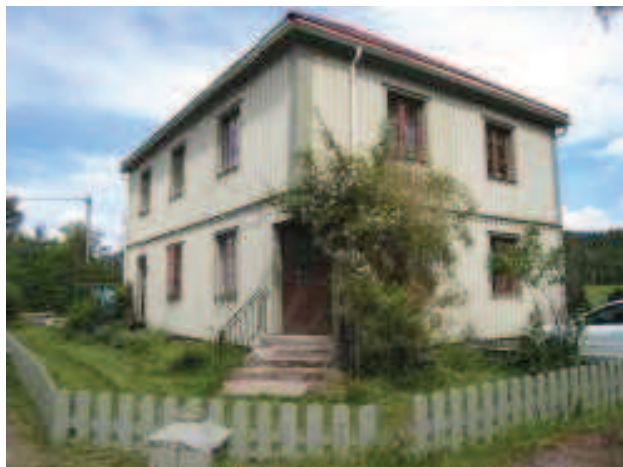
Bild 18. Före detta affär, idag bostad (Södra Ås 1:66). Byggt 1929. Huset var tidigare putsat med skyltfönster i nedervåningen.
