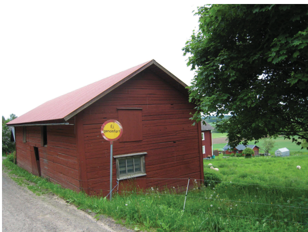
Bild 14. Ekonomibyggnaderna är knuttimrade och ligger tätt inpå vägen. Här ett fårhus i bruk, tillhörande När Nilspersan (Askersby 5:1).
