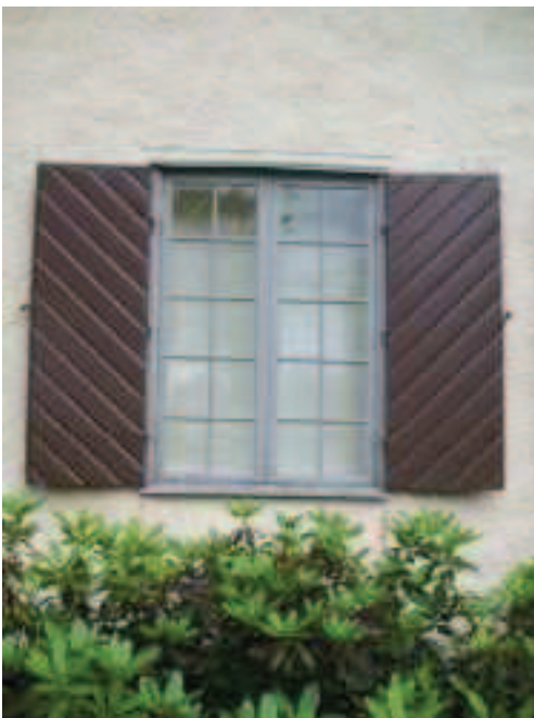
Bild 37. Detalj: fönster på Mårbackas manbyggnad
