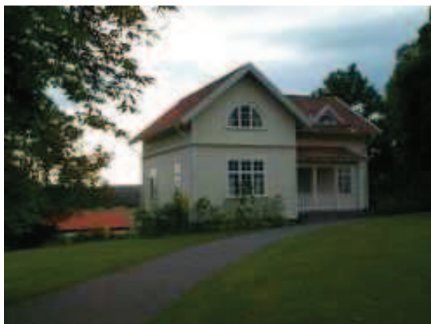
Bild 34. Den östra flygeln.
